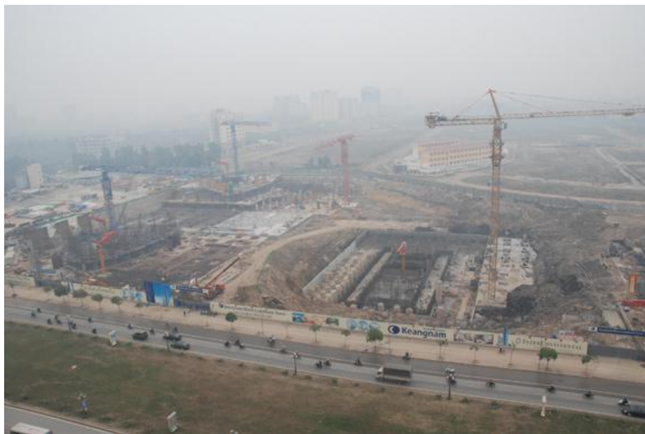
Công trường cuối năm 2009
