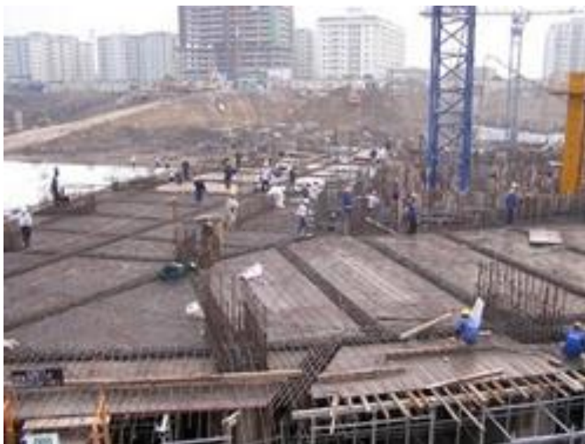
Công nhân trên công trường
