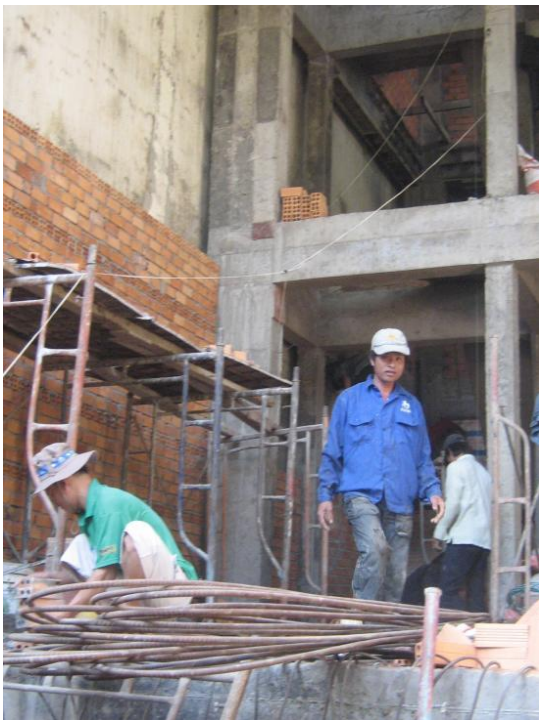
Hệ thống di chuyển cho công nhân trên các tầng cao
